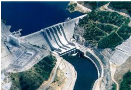
Υδροηλεκτρικό Φράγμα Ταυρωπού
